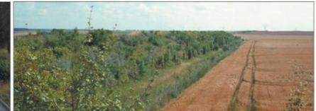
Exemple de merlon de protection acoustique sur la LGV Nord
